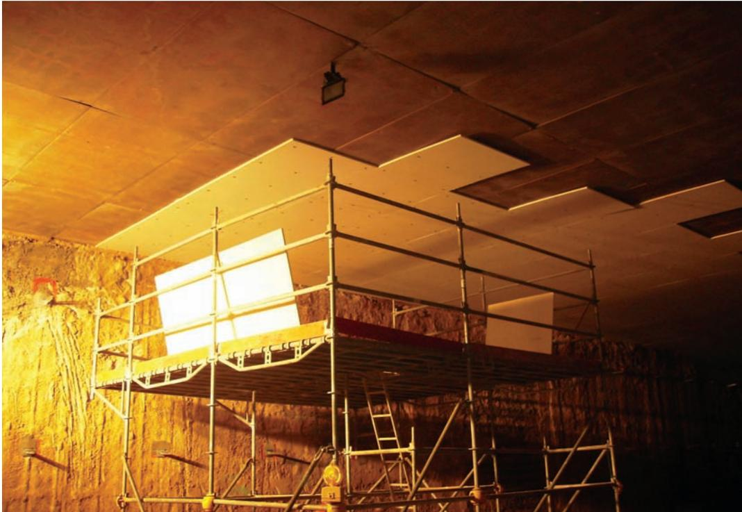
Experimentos con incendios estándar han demostrado que cuando el refuerzo carece de la protección requerida por el hormigón, esta temperatura crítica de aproximadamente 500 °C se alcanza a los 10 minutos de exposición al tipo de temperaturas que se esperarían en las condiciones de un incendio en un túnel.
