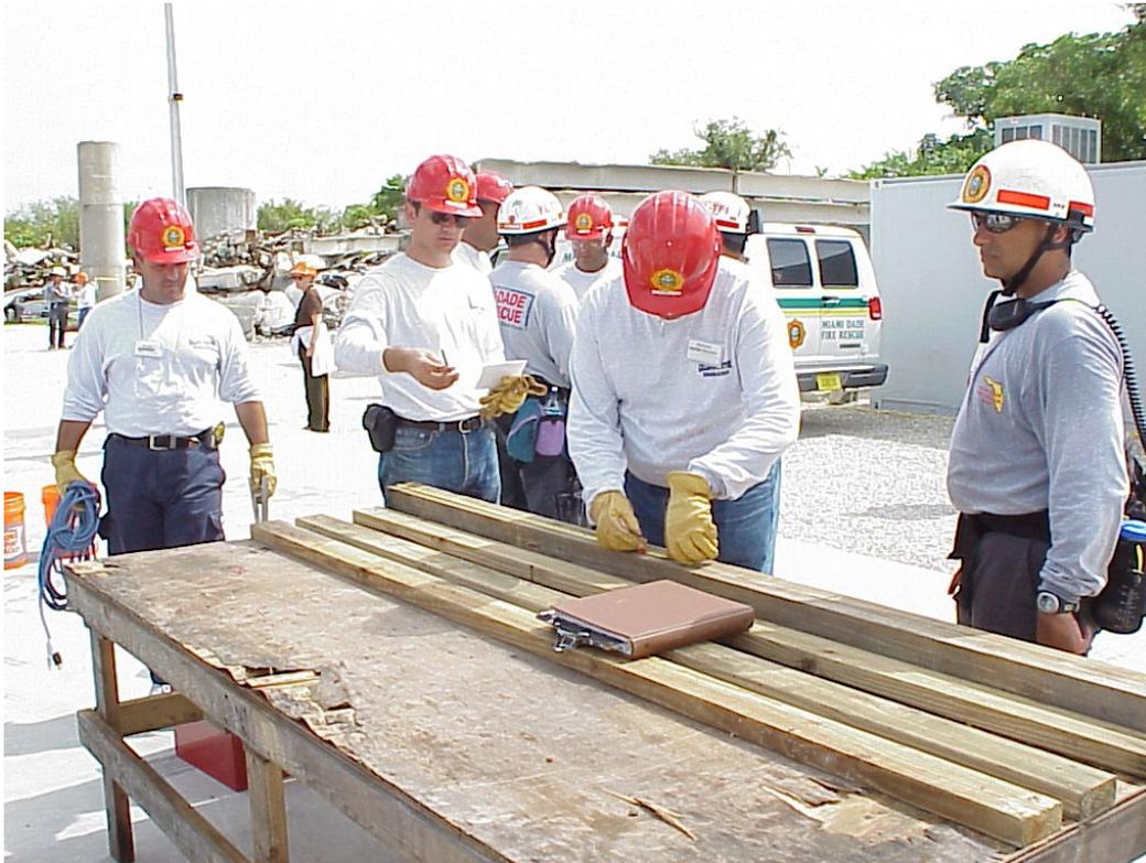
**El anotador pide las maderas que requiere al trazador y cortador en la mesa de corte**
