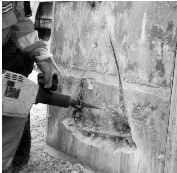
10. Rompa el triángulo de la base hacia arriba. ¡Tenga cuidado! No haga el corte muy profundo para evitar cortar elementos estructurales, líneas eléctricas, tubos de agua, etc.
