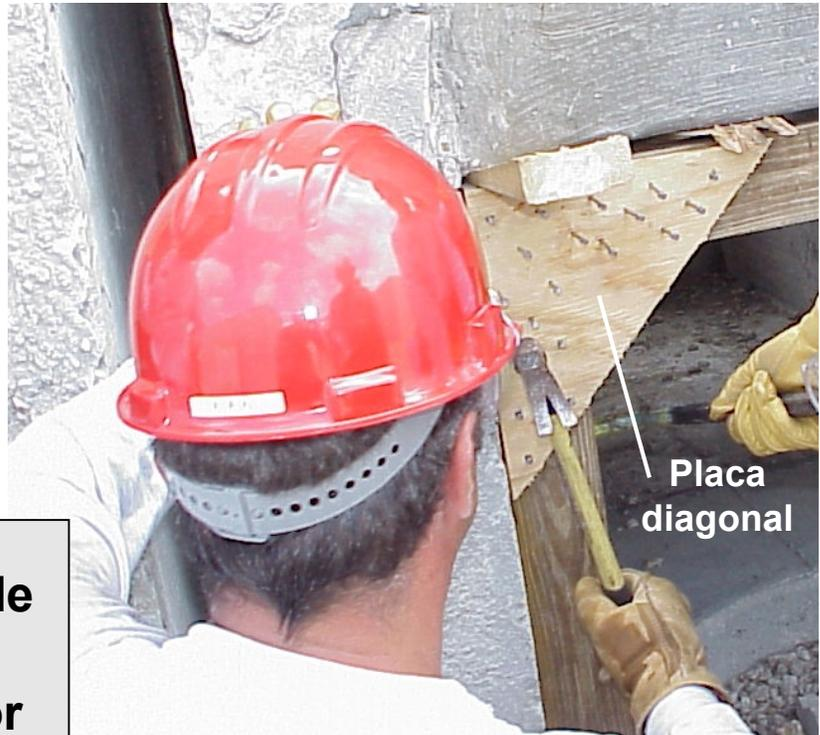
**Coloque la placa de unión diagonal en la esquina superior sin cuña, utilizando el patrón de 13 clavos de 2 1/2"**
