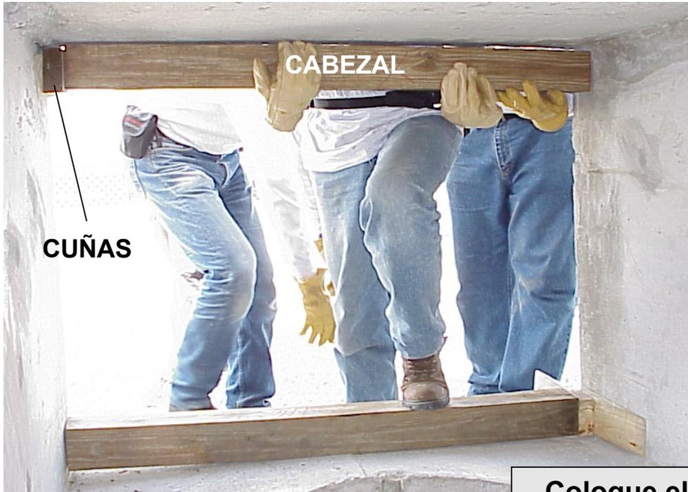
**Coloque el cabezal en el borde superior de la ventana con cuñas de 5 x 10 cms. pero del lado opuesto al de la base**
