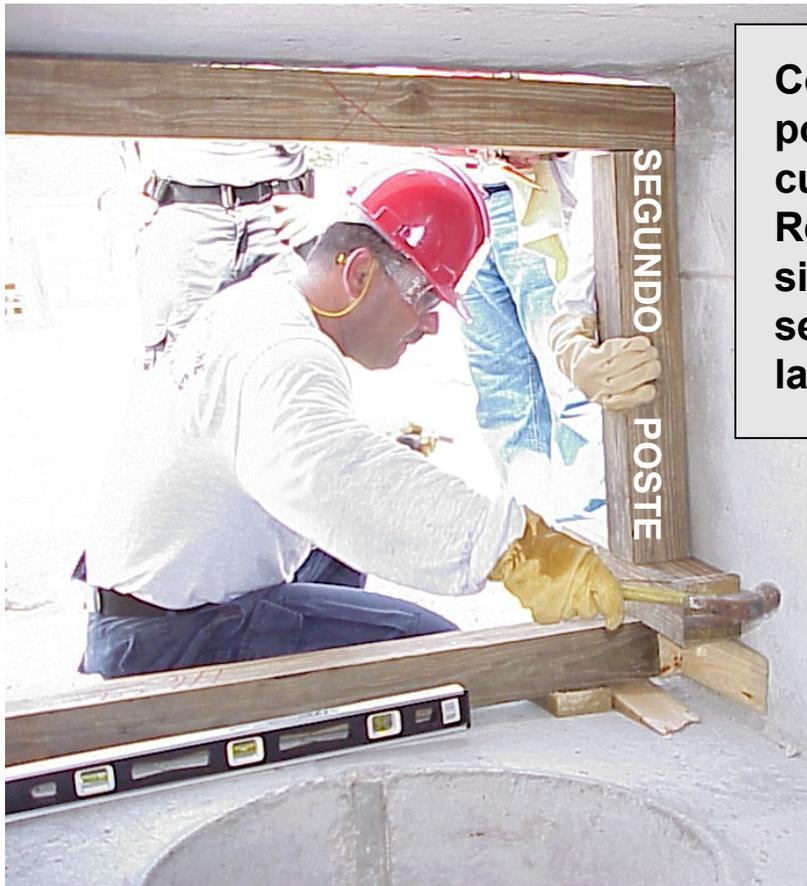
**Coloque el segundo poste y ajuste con cuñas otra vez. Recuerde golpear simultáneamente y en sentido contrario sobre las cuñas**
