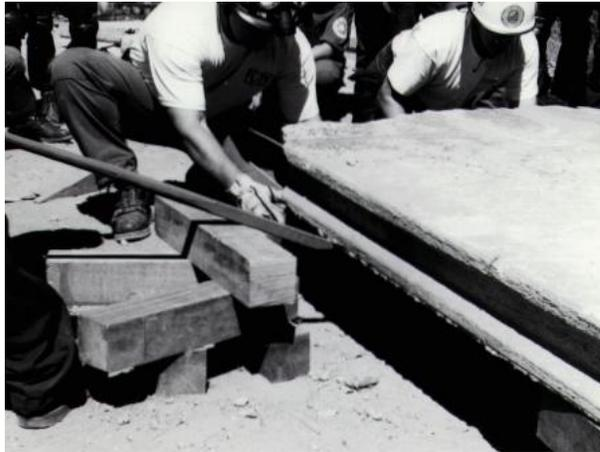
Otras dos maneras seguras de colocar el punto de apoyo para levantar la carga.
