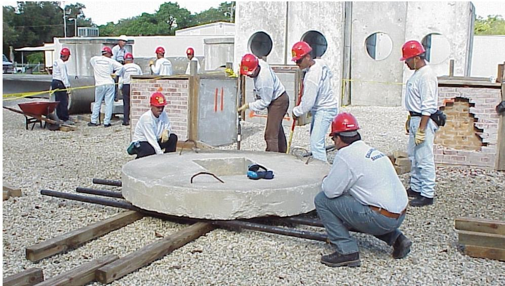
2. Empujar la carga mediante el sistema de palanca de segunda clase en la dirección deseada del movimiento
