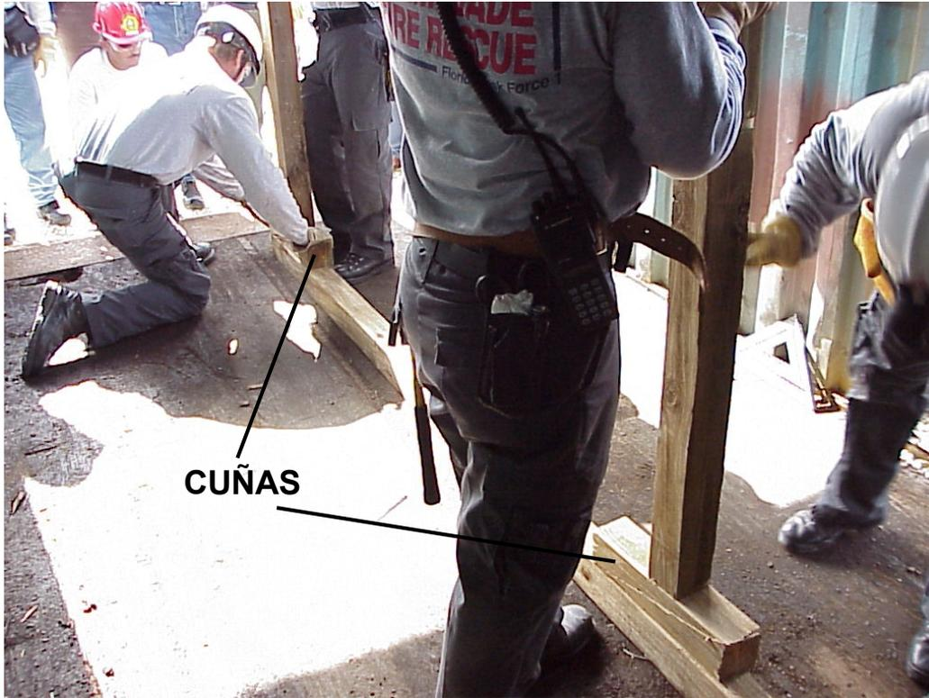
**Coloque los postes y el cabezal sobre la base.
