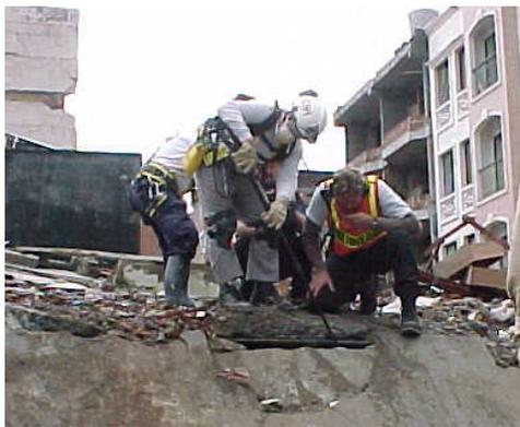
REQUIERE DE EQUIPOS Y PERSONAL ESPECIALIZADO EN DETECCIÓN DE SONIDOS, TEMPERATURA, VIDEO, VIBRACIONES, ETC. PUEDE EFECTUARSE CON EQUIPOS DISEÑADOS ESPECIALMENTE PARA ELLO O CON EQUIPOS IMPROVISADOS DE ADAPTACIÓN LOCAL.
