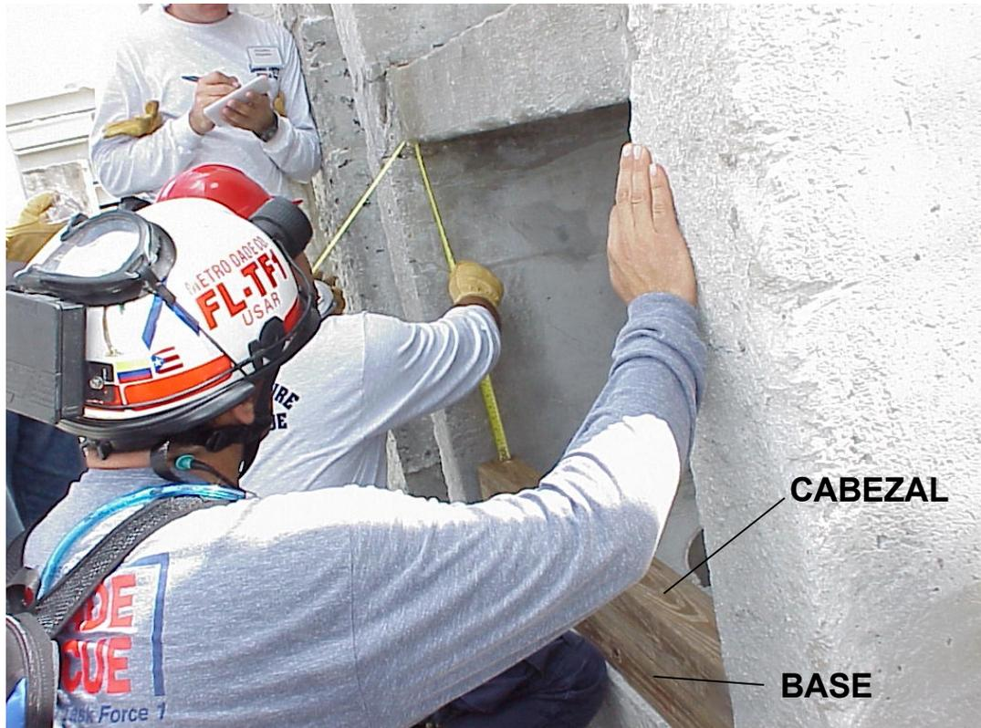
**Coloque la base y el cabezal, uno encima del otro. Tome las medidas de los postes (dos medidas, una en cada extremo). Réstele 8 cms. (espacio para las cuñas). Déle esa medida al anotador**
