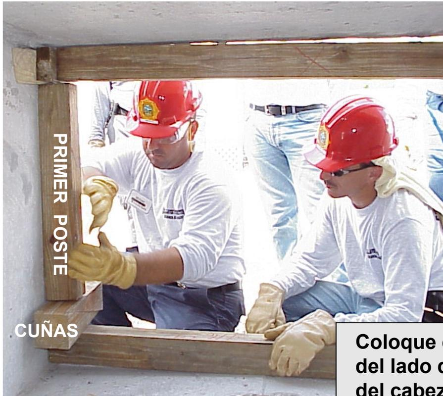
**Coloque el primer poste del lado de las cuñas del cabezal y ajuste con golpes de martillo las cuñas del lado de la base**
