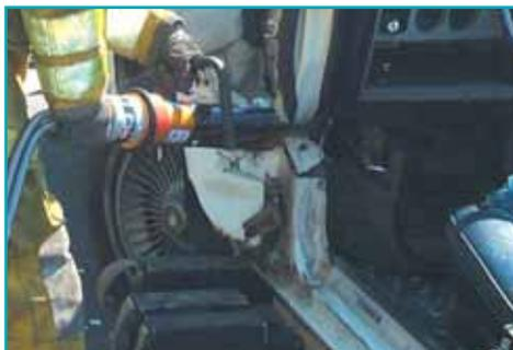
Corte una sección, semejante a la enunciada anteriormente en la parte de acceso al área de los pies que sirva para insertar las puntas de su separador. Coloque los bloques exactamente debajo del poste A.
