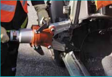
Las puntas del separador se colocan en el área de inserción y se puede iniciar el levantamiento.
