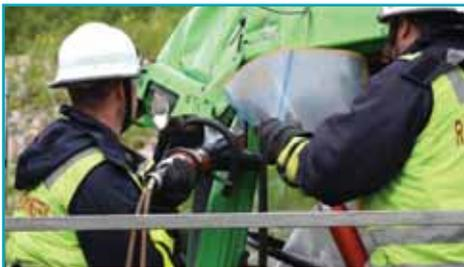
Corte la parte alta del poste A de la cabina y haga cortes de alivio a través de la base del poste A, también en el frente del área del tablero, con el fin de lograr un empuje frontal del tablero.
