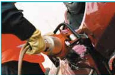
Utilice el separador para reventar el mecanismo de la cerradura, separando la puerta de su estructura y continúe con la retirada como se explicó mas arriba.
