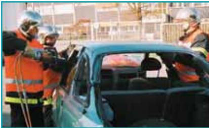
Con el techo sostenido, haga el corte final en los postes B y A del otro lado asegurándose que no existan otros puntos de sujeción tales como los cinturones de seguridad o alguna parte plástica.
