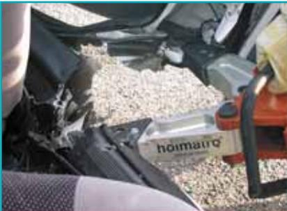
Continúe separando, reposicionando las puntas del separador hasta que el poste B sea separado de su base o hasta que se haya creado suficiente espacio para completar la operación con una cizalla.
