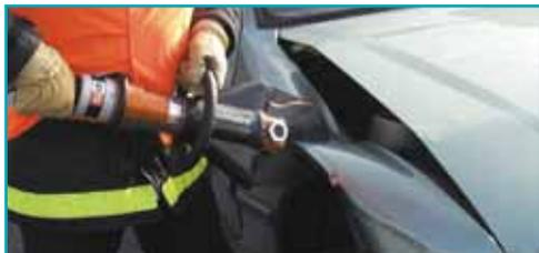
Si el guardabarros necesita ser retirado después, proceda a realizar un corte de alivio donde fue comprimido.
