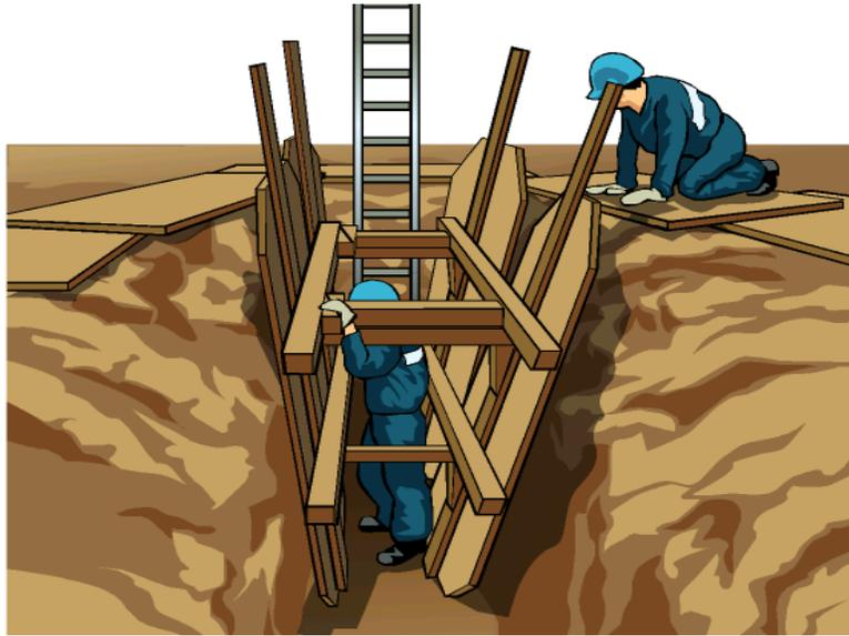
Una vez realizada la instalación de los maderos de 4"x 4" y habiendo ya realizado la fuerza en la parte superior, se debe iniciar el aseguramiento de la parte inferior. Siempre se debe tener presente que las cuñas deben ir en el mismo lado, y este debe ser el derecho, mirando desde la escala hacia la zanja, esto porque al pasar los que son derechos rotan hacia ese lado y no botaran las cuñas, lo que si pasara debilitaría el sistema.
