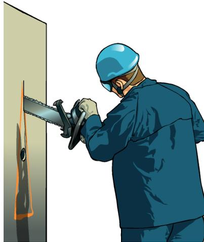
Al cortar con una espada diamantada un muro, realice primero una marca en forma de triángulo.
