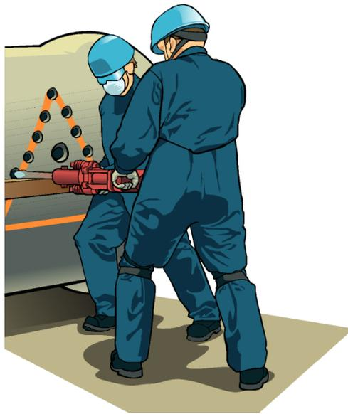
Al romper con un rompe concreto un muro, realice primero una marca en forma de triángulo. Inicie el rompimiento en la punta superior por un lado, luego el siguiente lado, así sucesivamente, al final la parte baja, deje siempre un margen de 5 cm. sin cortar en cada esquina, estos los debe realizar al final de trabajo. El final utilice un combo para romper el concreto.
