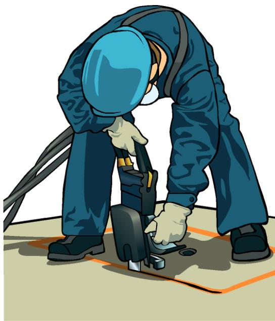
Al cortar con una espada diamantada una losa, realice primero una marca en forma de cuadrado.
